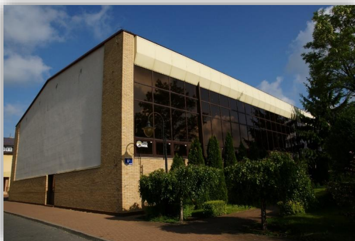
Rysunek 4. Budynek Hali Sportowo – Widowiskowej w Baboszewie.
